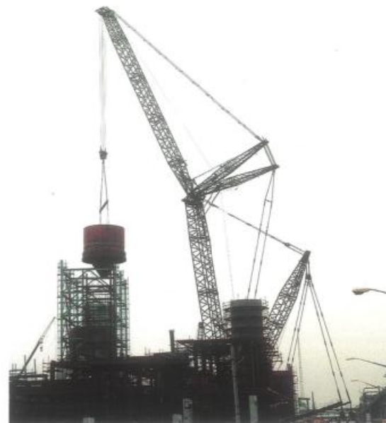
800t 吊车在扬子石化炼油厂进行焦炭塔吊装（重量 220t）
