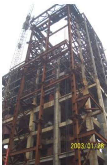
双环的框架法施工
