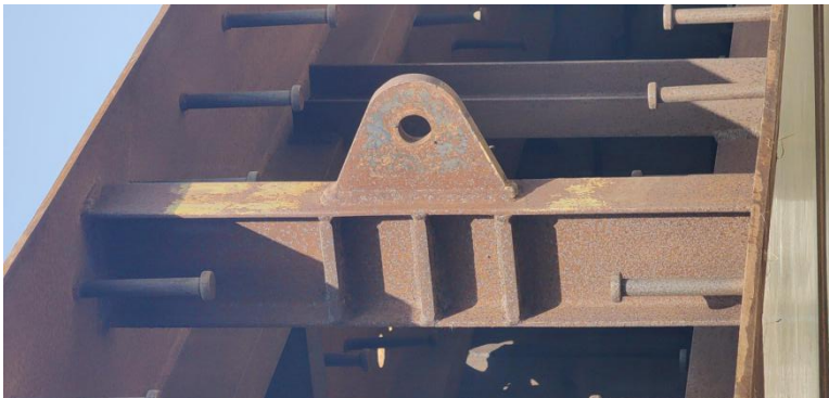
图 1 吊耳组件安装梁
