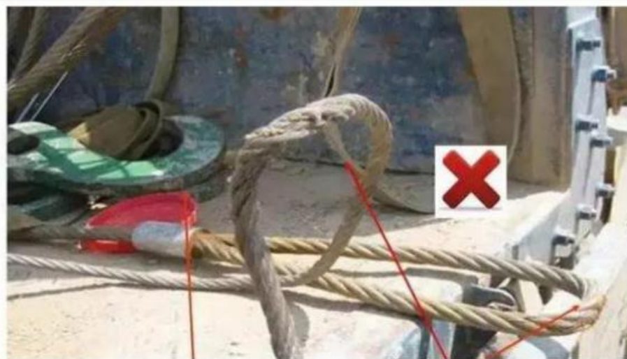
现场制作的吊钩
